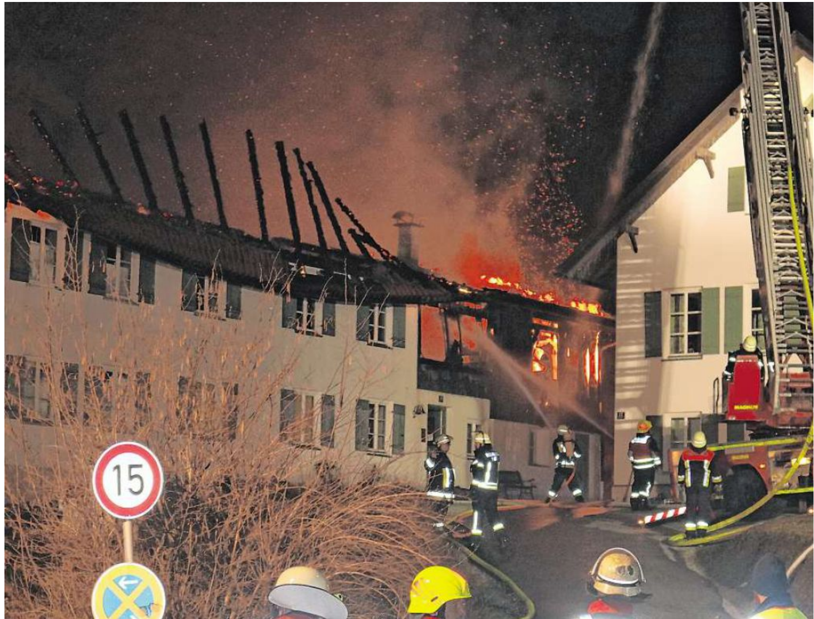
In der Nacht zum Mittwoch hat in Hohenschwangau das Verwaltungsgebäude des Wittelsbacher Ausgleichsfonds gebrannt. Verletzt wurde niemand, den Schaden schätzen Polizei und Feuerwehr auf etwa eine Million Euro. Die Brandursache ist noch unklar.
